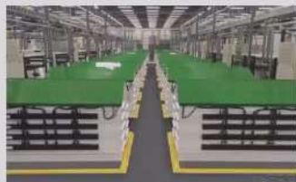
Green Revolution Cooling 设计系统中采用 Electrosafe的矿物油
