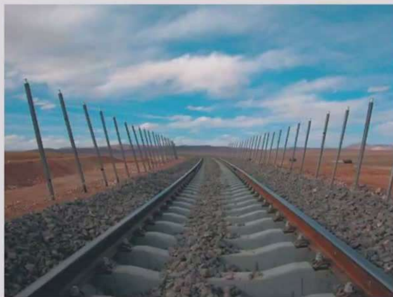
青藏铁路两侧采用重力热管技术解决冻土稳定性问题
